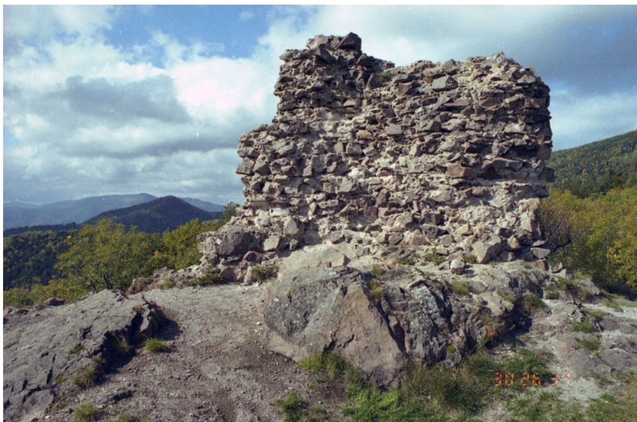
Vestiges de l'habitation, vers l'ouest.
